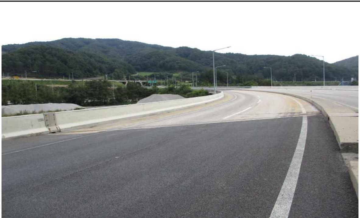
교량 상부 전경
